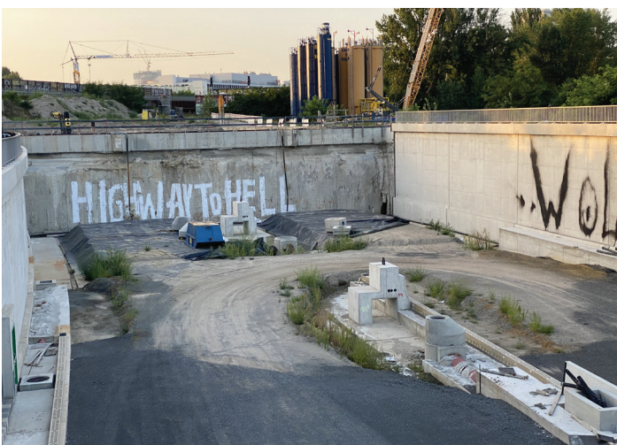
Blick auf die Baustelle der umstrittenen Fortführung der Stadtautobahn A100.
